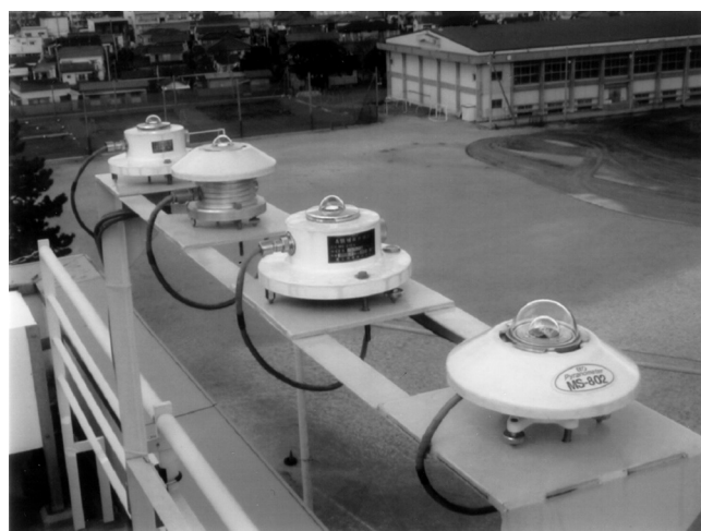
写真5 研究所屋上に設置した紫外線計測装置
